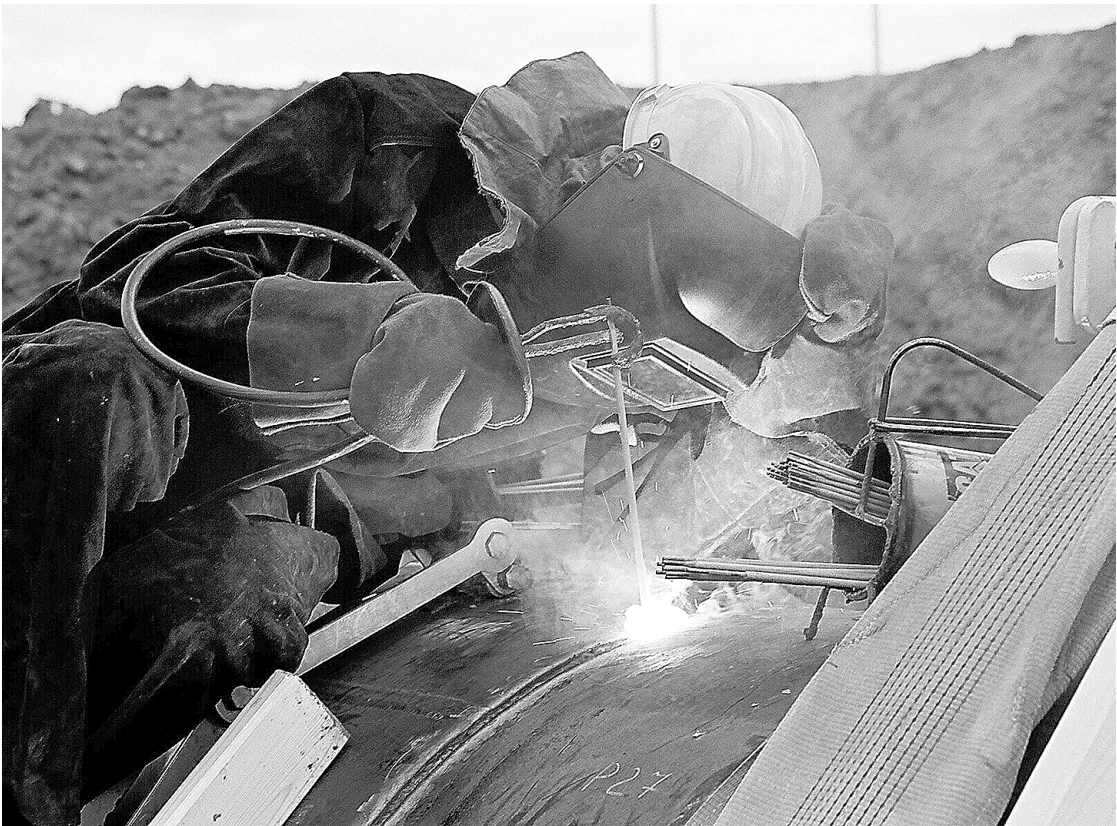
Ремонтные работы на газопроводе-отводе в г. Владимире.
